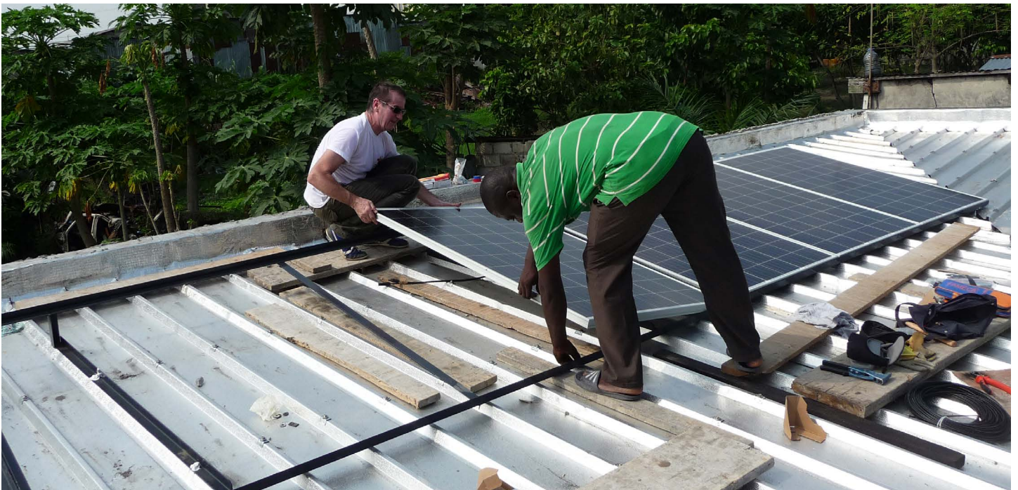
Centre de santé de Voka et Moukondo (Congo Brazzaville) soutenu par le Syndicat Départemental d'Énergie Électrique de la Gironde
