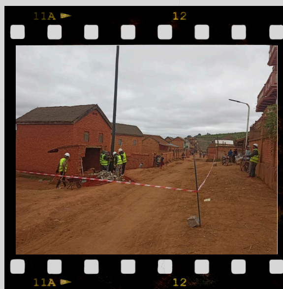
Travaux sur le réseau BT
